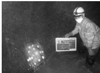
写真-7 止水注入工完了状況
