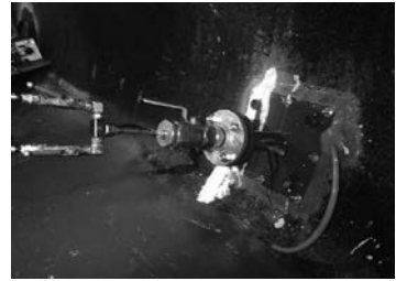
写真-6 止水注入工施工状況②
