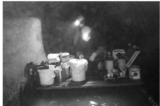
写真-3 施工箇所の仮設状況
