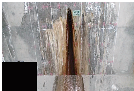
写真-8 場所打ち洞道 漏水箇所
