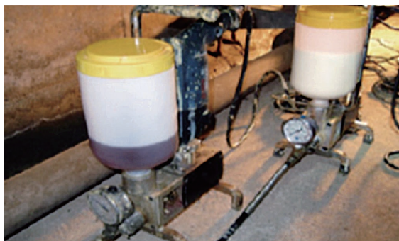
写真-2 注入状況 (1)
