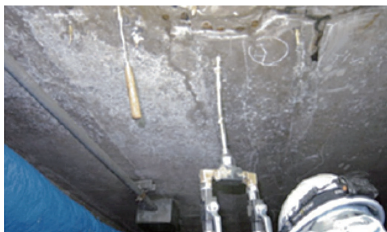
写真-3 注入状況 (2)
