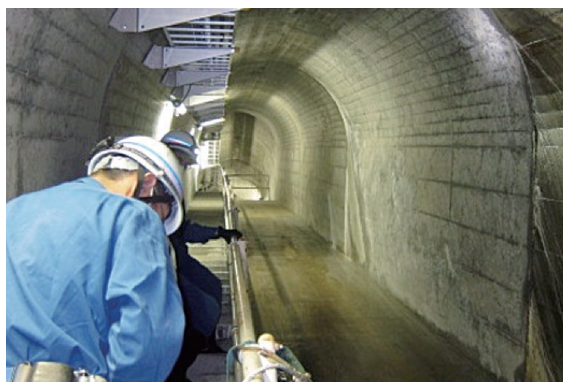
写真-7 ダム監査廊 漏水状況
