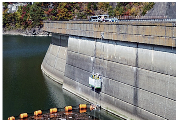
写真-10 ダム堤体での施工状況 (1)
