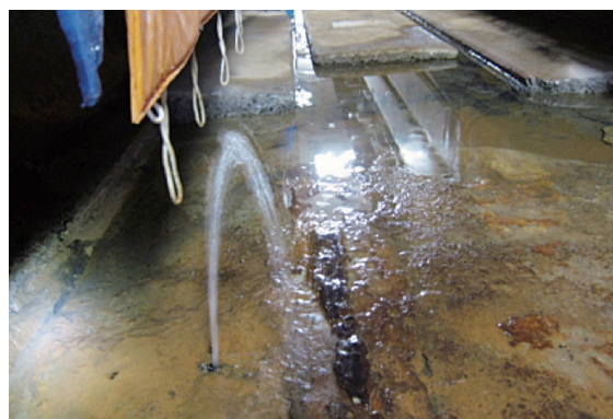
写真-9 場所打ち洞道 漏水箇所
