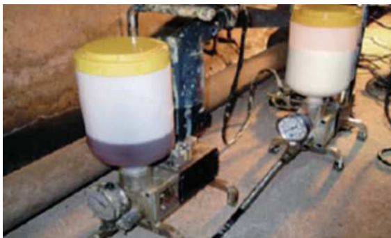
写真-2 注入状況 (1)
