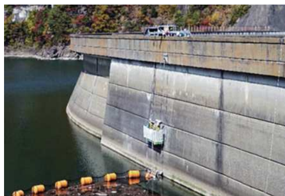
写真-10 ダム堤体での施工状況 (1)
