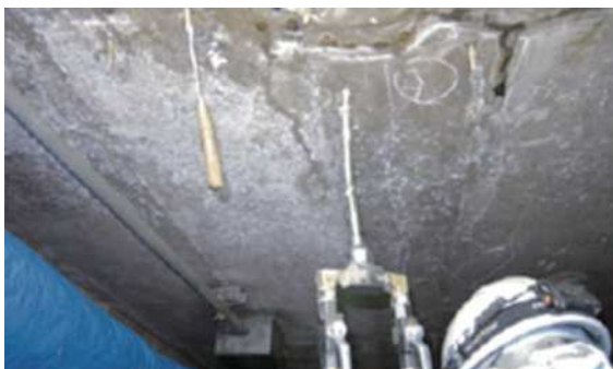
写真-3 注入状況 (2)
