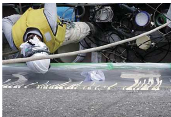
写真-11 ダム堤体での施工状況 (2)
