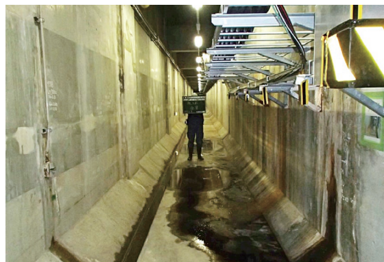
写真-4 下水管廊止水施工（施工前）
