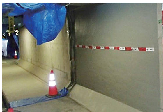
写真-6 下水管廊止水施工（施工後）
