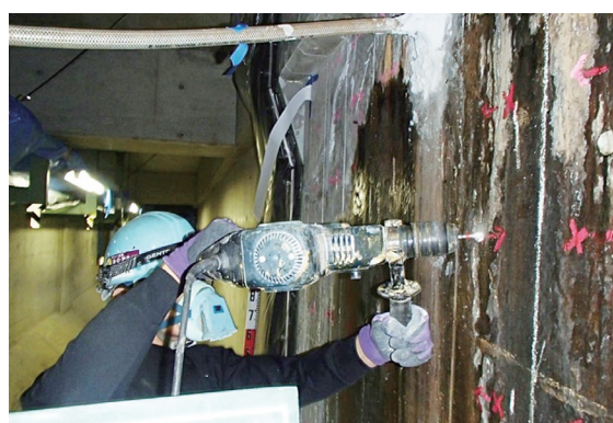
写真-5 下水管廊止水施工（施工中）
