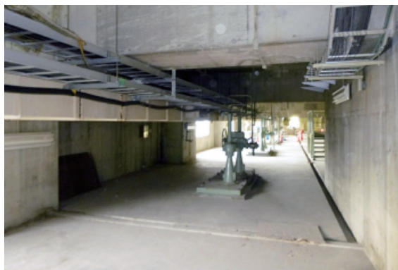
写真-8 水再生センター天井止水施工（施工後）
