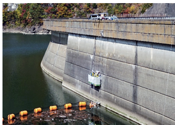
写真-12 ダム堤体施工状況
