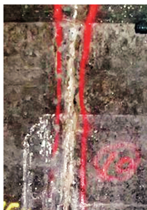
写真-11 下水本管 管更生前（止水後）
