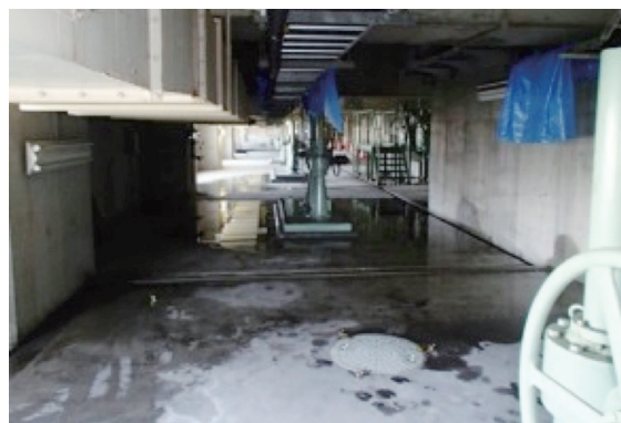
写真-7 水再生センター天井止水施工（施工前）
