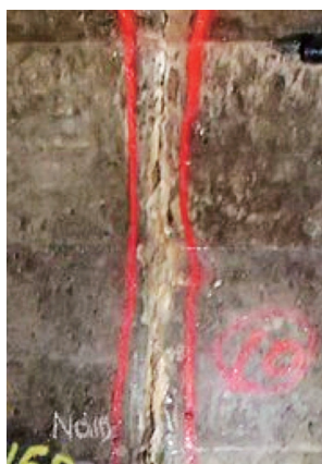
写真-10 下水本管 管更生前（止水前）
