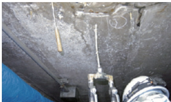
写真-2 注入状況②
