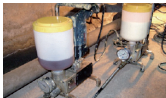
写真-1 注入状況①
