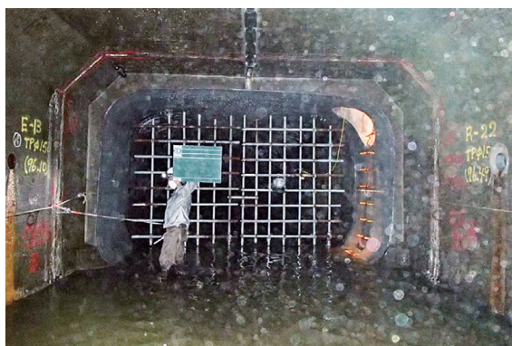
写真-9 下水本管 管更生前（全体）
