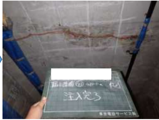
ひび割れ漏水補修 施工後
