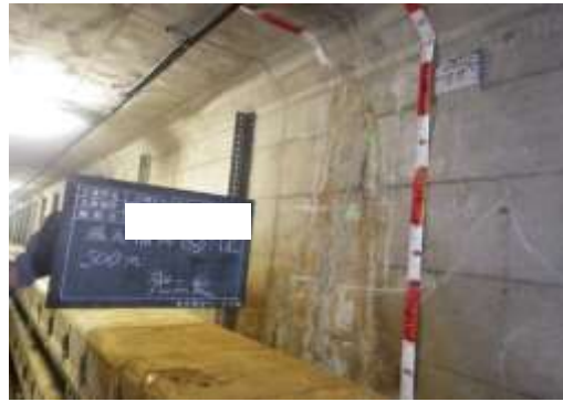
ひび割れ漏水補修 施工後
