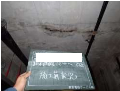
ひび割れ漏水補修 施工前
