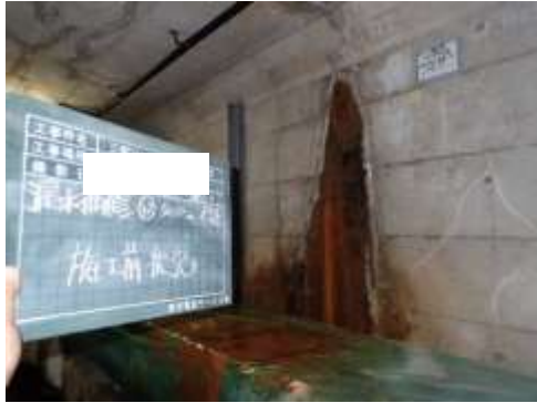
ひび割れ漏水補修 施工前
