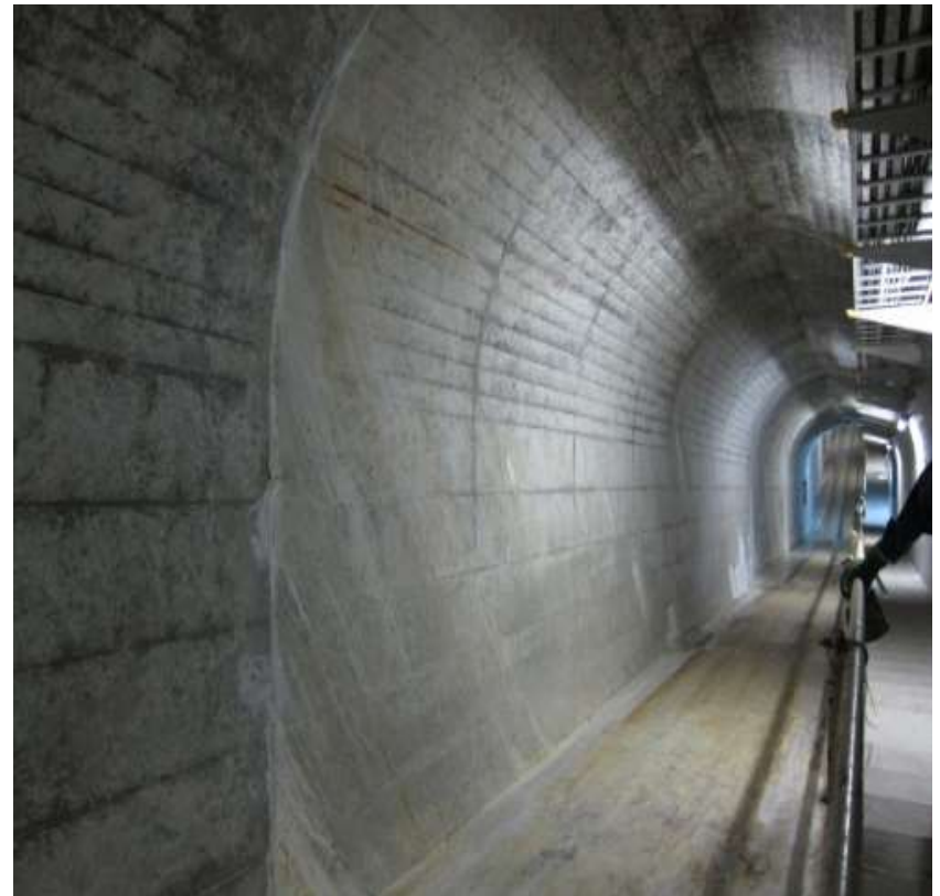
2013年12月（施工後） 漏水なし
