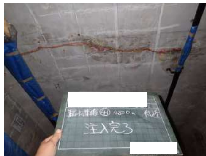
ひび割れ漏水補修 施工後
