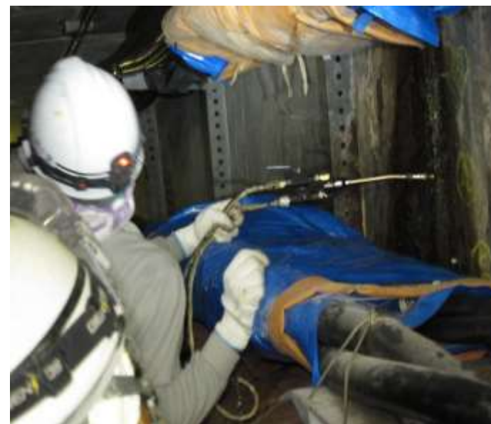
写真-1 注入状況写真
