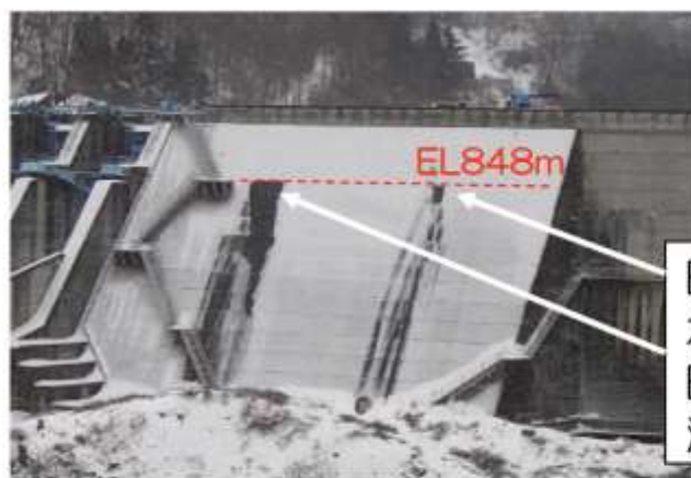
スラストブロック背面状況
