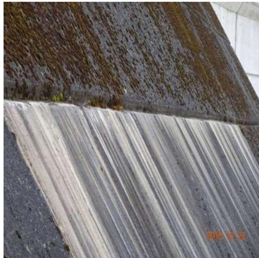
注入完了直後 （リークした注入材除去前）
