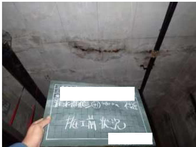
ひび割れ漏水補修 施工前
