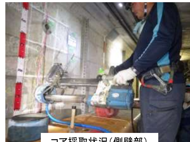
コア採取状況(側壁部)
