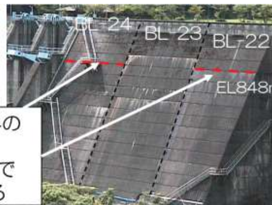
スラストブロック背面状況
