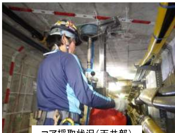
コア採取状況(天井部)
